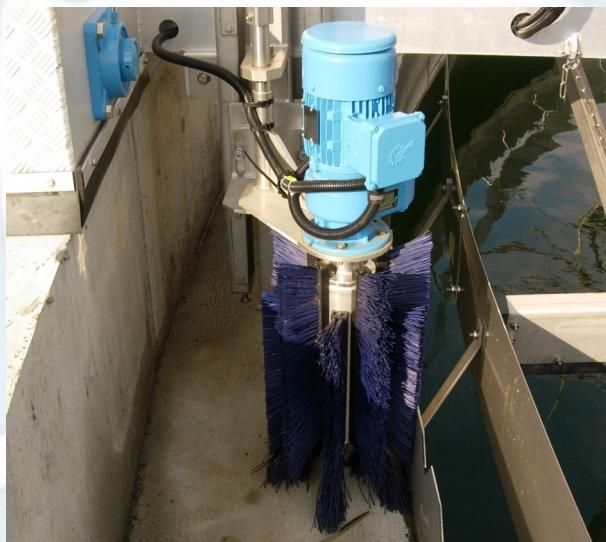
La brosse rotative de nettoyage est conçue pour éliminer en continu les dépôts, algues et biofilms formés sur les parois et goulottes des clarificateurs. Installée sur le pont racleur ou sur un support dédié, elle fonctionne par rotation lente et régulière, assurée par un motoréducteur étanche. Les balais en fibres techniques garantissent un brossage efficace sans endommager les surfaces. L'ensemble est conçu pour résister aux milieux humides et agressifs.
